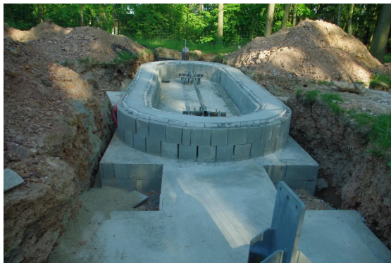
Základy nové Hýlačky, foto z 28. května
